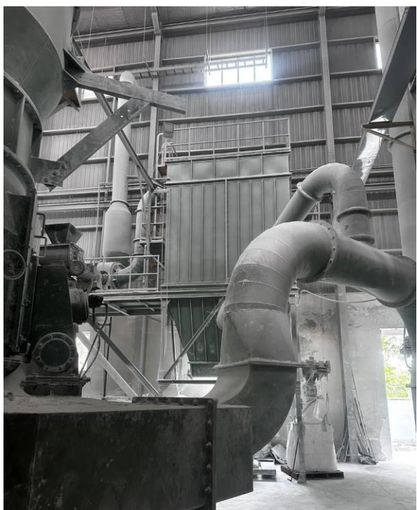
Hình 3.8. Một số hình ảnh minh họa hệ thống xử lý bụi của cơ sở.
